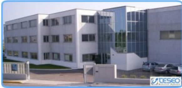
Sede principale di Desenzano
